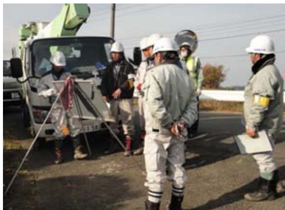
御船町地域情報通信基盤整備工事においてミーティングに参加
