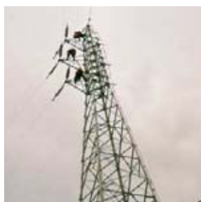
営巣防止対策作業状況
