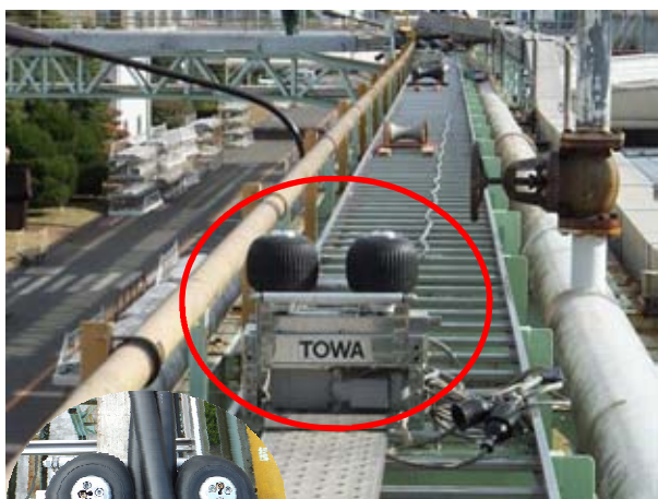
パワーボール設置状況
