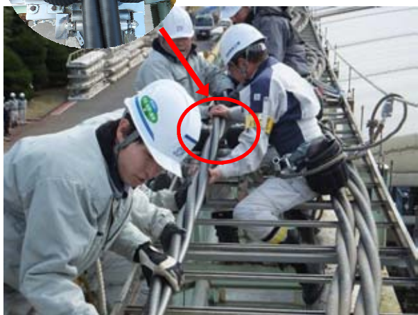
高圧ケーブル布設状況
