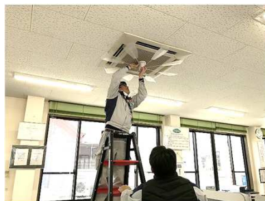
取付作業の様子
