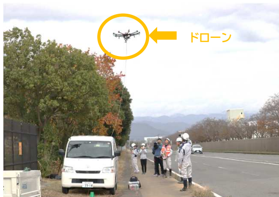
ドローンを使用した作業時の様子
