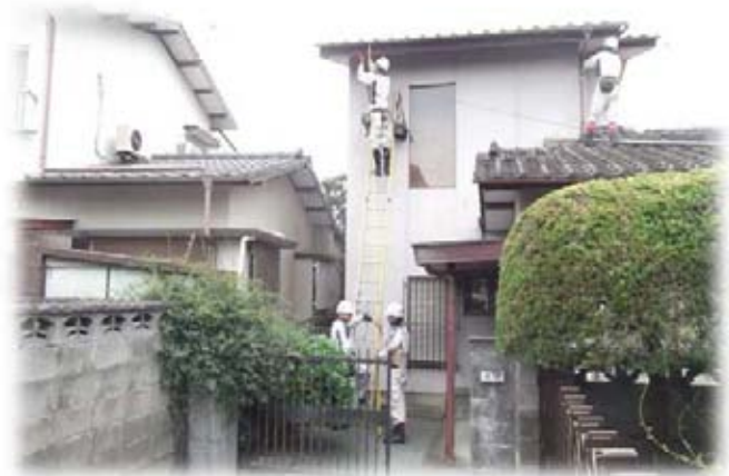
インターネット提供工事
