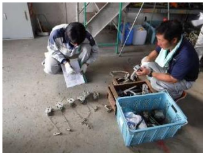
日奈久田浦線(架線工事) 持ち出し時、点検整備の実施
