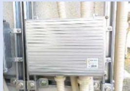
設置したPV計測ユニット
