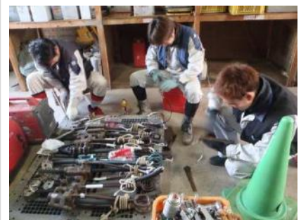
内谷送電線(架線工事) 工具返却時、点検整備の実施
