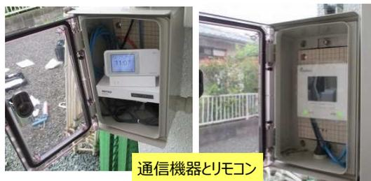
「しらさぎ旧保養所」の出力抑制のための通信機器増設工事は、出力抑制のスケジュールを取得するためパソコン内に通信機器（ポケットWi-Fi）を増設しました。
