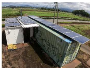
倉庫上に積まれた太陽光パネル
