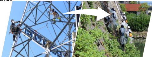
鉄塔工事の技術を発揮
